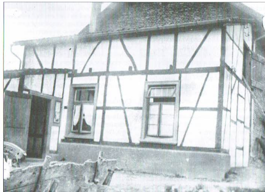
De schuur van Frans Corten waar in de bijbouw de eerste katholieke school van Bergneustadt werd begonnen.
