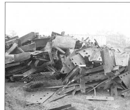
Het restant van de afgebroken 'brekerij'.
